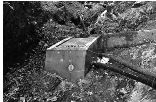
図7 完成した新しい取水口(2017年11月26日、竹内留哉撮影)
