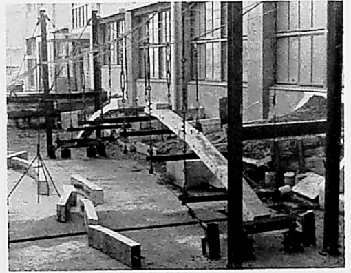
写真-5 基本アーチリングの架設実験
