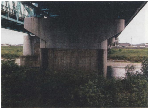
写真-2.6 P5 橋脚 外観
