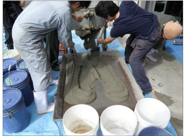
写真-3.8 練り混ぜ状況 (排出時)
