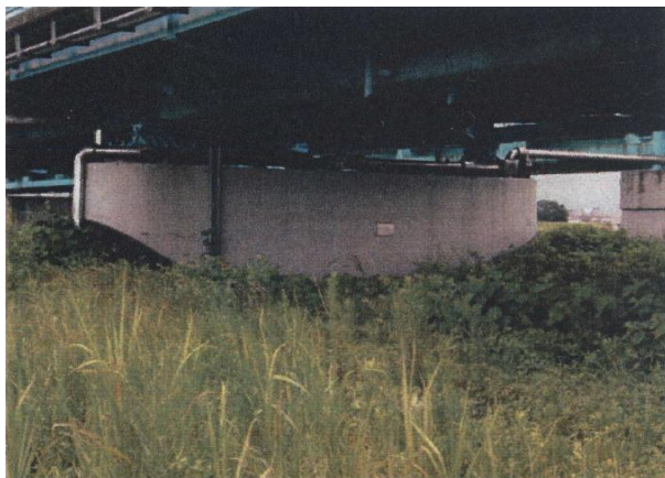
写真-2.2 P1 橋脚 外観
