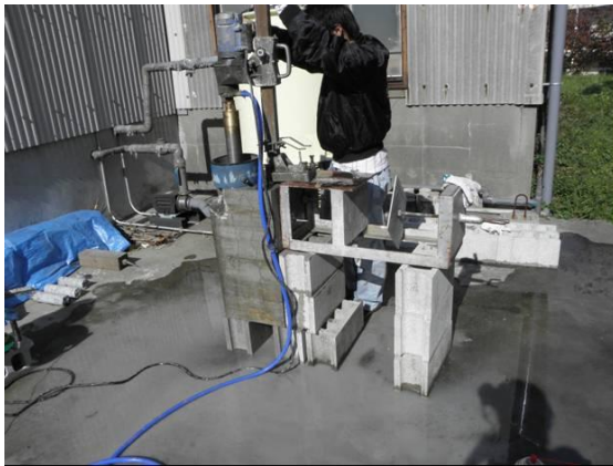
写真-5.3 コアマシン設置状況
