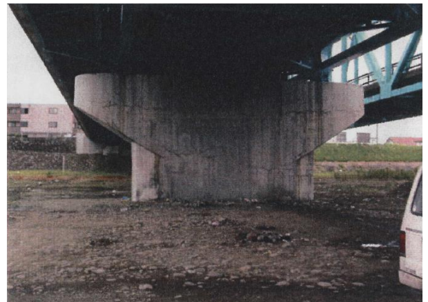
写真-2.7 P6 橋脚 外観
