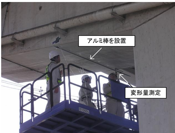
写真-6.1 変形計測状況
