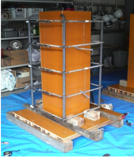
写真-3.1 主鉄筋配置状況
