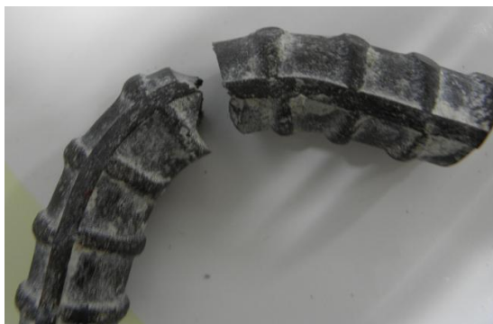
写真-4.1 case13・C鉄筋（破断）
