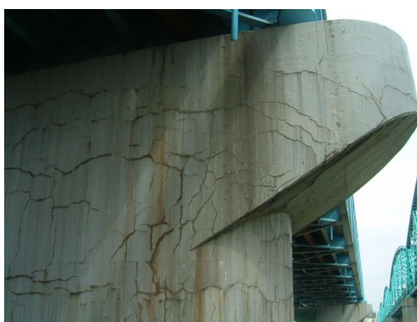
写真-2.8 梁下部に発生したひび割れ
