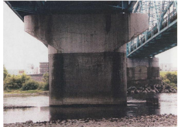
写真-2.5 P4 橋脚 外観
