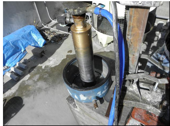
写真-5.4 コア採取作業状況
