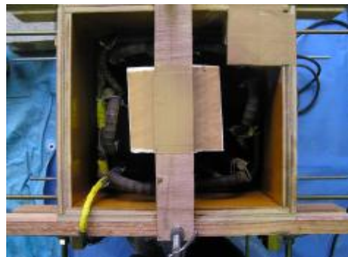
写真-5.2 型枠設置状況
