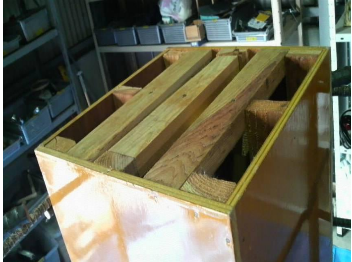
写真-3.2 内部型枠 外観
