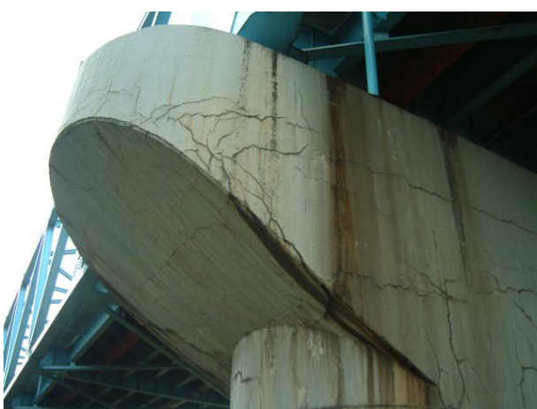
写真-2.8 梁下部に発生したひび割れ
