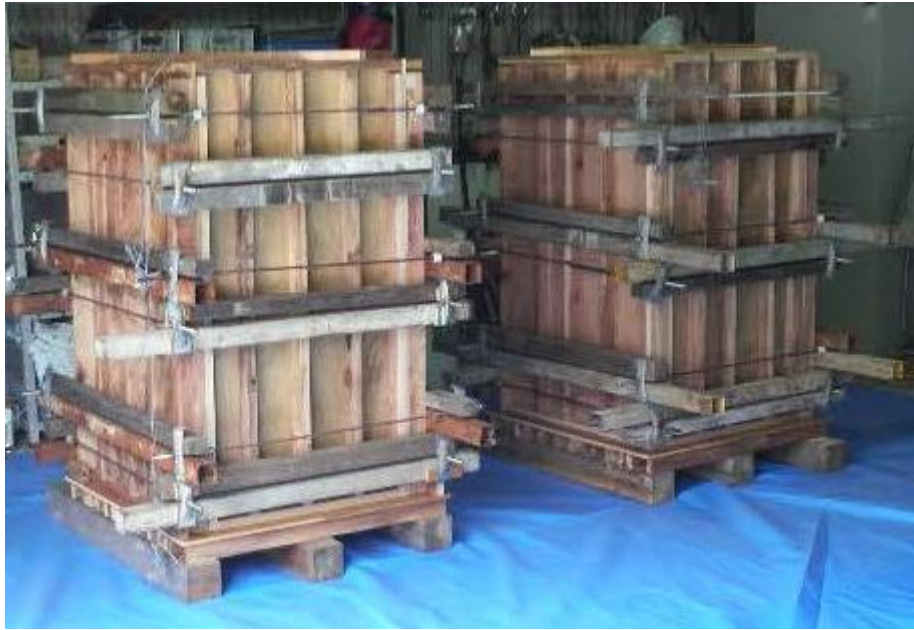
写真-3.4 完成型枠 外観
