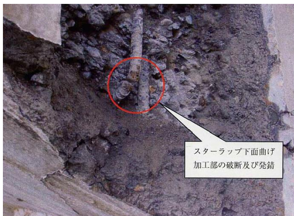
写真-2.9 鉄筋破断状況
