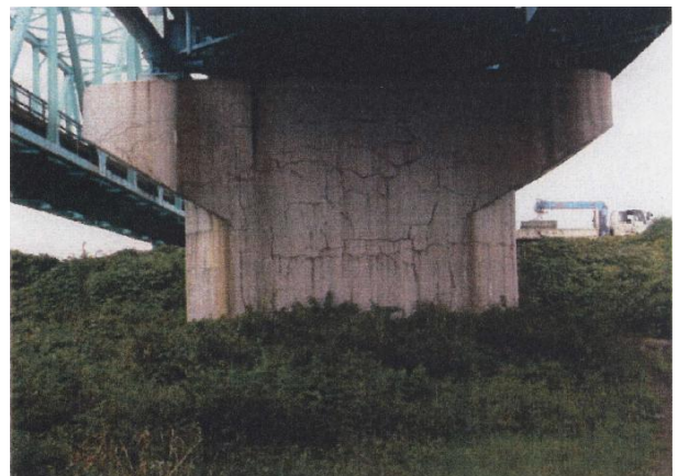
写真-2.3 P2 橋脚 外観
