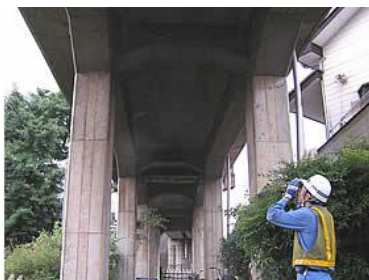
図 1.4 目視調査の様子
