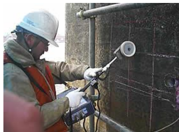
(a) 自然電位による測定の様子
