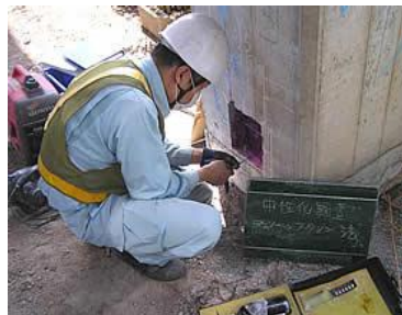
(b) 中性化深さ測定状況
