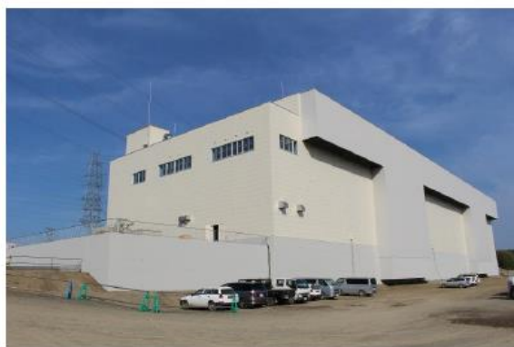
<蓄電池建屋外観>
